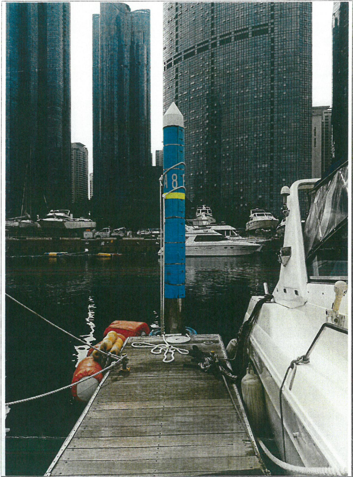
폰툰 파일 표시선(형광색 야간 반사지) 위쪽 계류색(훗줄) 보강 현장사진 예시
